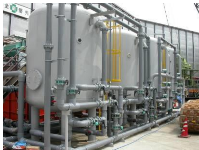
図 6. 宝塚市寺畑前川 洪水調節池工事：湧水ヒ素除去
