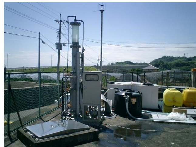
島原市水道局浄水場にて硝酸イオン除去 生物脱窒実験
